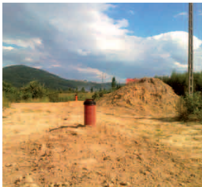
Kanalizacja osiedle Stara Wieś – Tęgorozze
