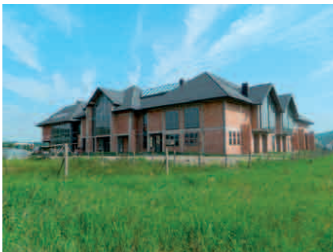
Budynek Wielofunkcyjny w Łososinie Dolnej
