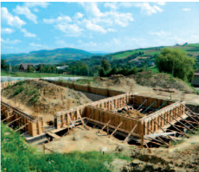
Ławy fundamentowe sali gimnastycznej
