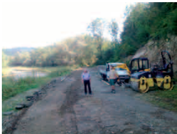
Łososina Dolna – most Wronowice – Tłoki – 115 tys.
