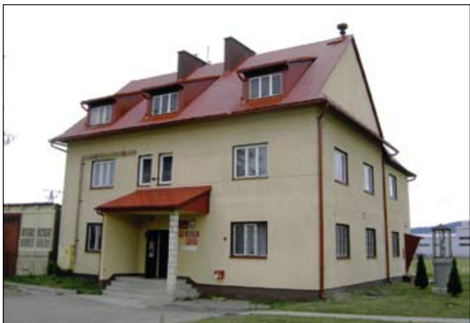
OSP ŁOSOSINA DOLNA Malowanie dachu, rynien, okien w poddaszu, wykonanie posadzki, montaż drzwi – koszt 10 000 zł
