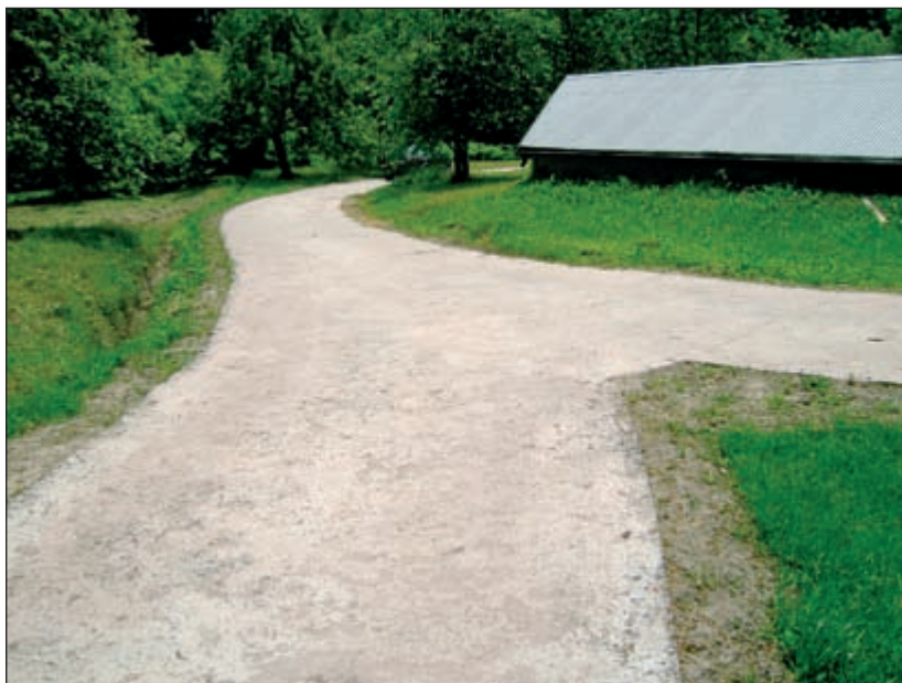
Zawadka / Baran, Bocheński/ 100 mb drogi betonowej - 6.405 zł
