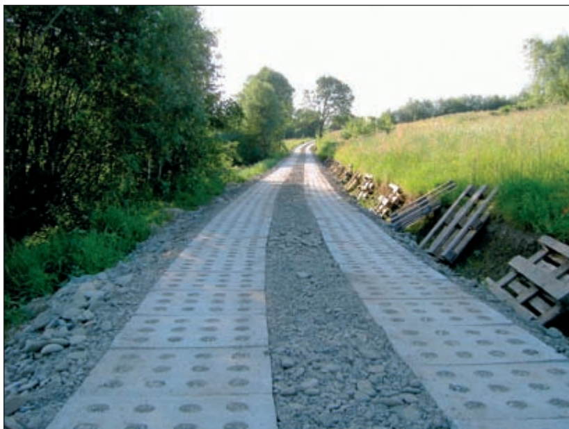
Tabaszowa /Joniec/ 400 mb płyt betonowych
