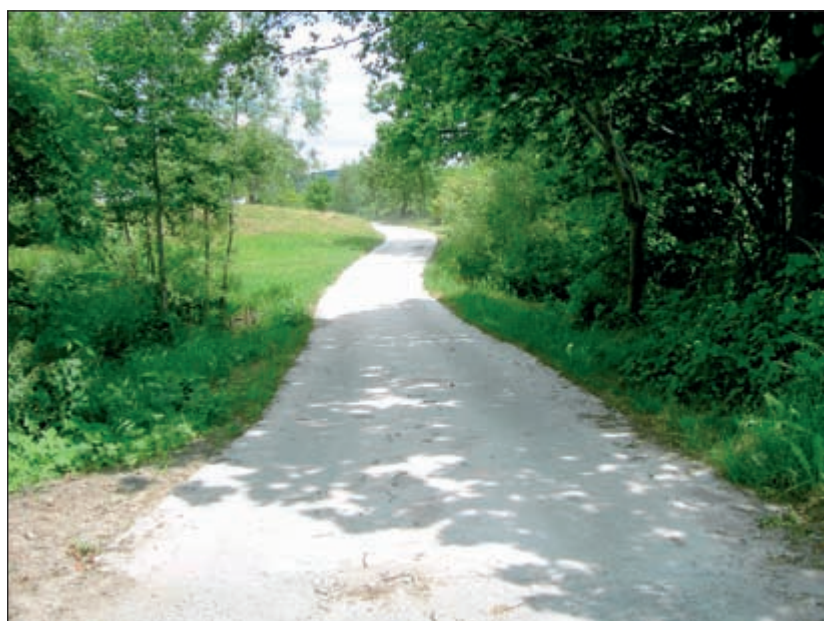
Łososina Dolna /Załubski, Kocoń/ 200 mb drogi betonowej - 16.514 zł
