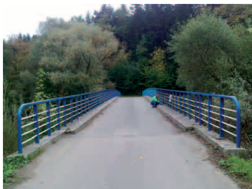
Malowanie barier na 5 mostach gminnych (Łososina Dolna – Instytut, Żbikowice, Zawadka, Świdnik -2 mosty)
