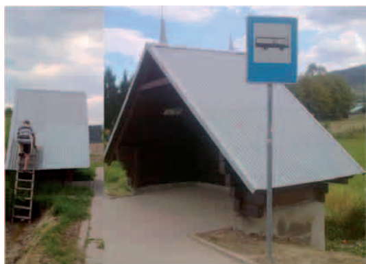
Remont wiaty przystankowej i słupków w Tęgoborzy.
